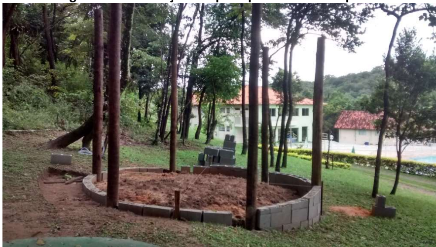
Figura 01: Construção de quiosques – Sede Campestre
