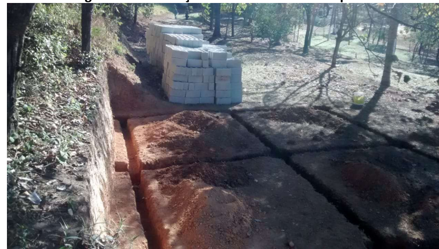
Figura 07: Construção de Chalés – Sede Campestre
