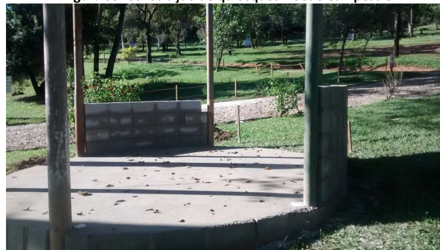
Figura 03: Construção de quiosques – Sede Campestre
