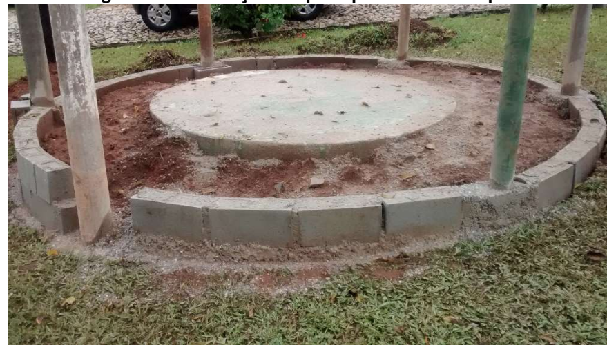
Figura 02: Construção de quiosques – Sede Campestre
