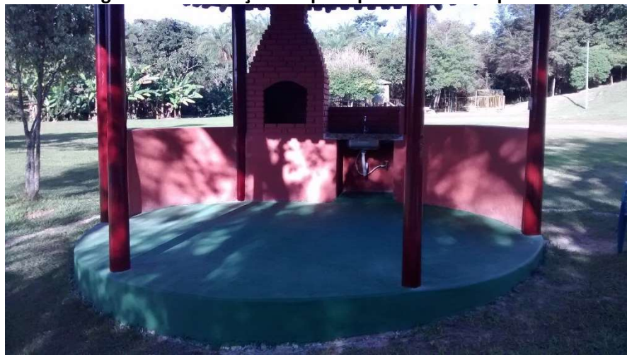
Figura 05: Construção de quiosques – Sede Campestre
