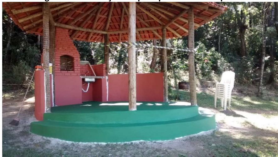
Figura 04: Construção de quiosques – Sede Campestre
