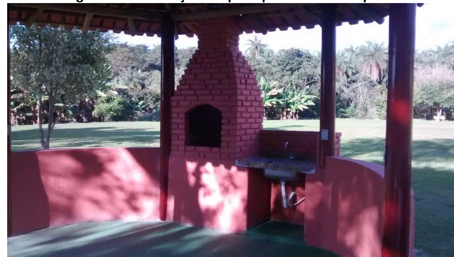
Figura 06: Construção de quiosques – Sede Campestre
