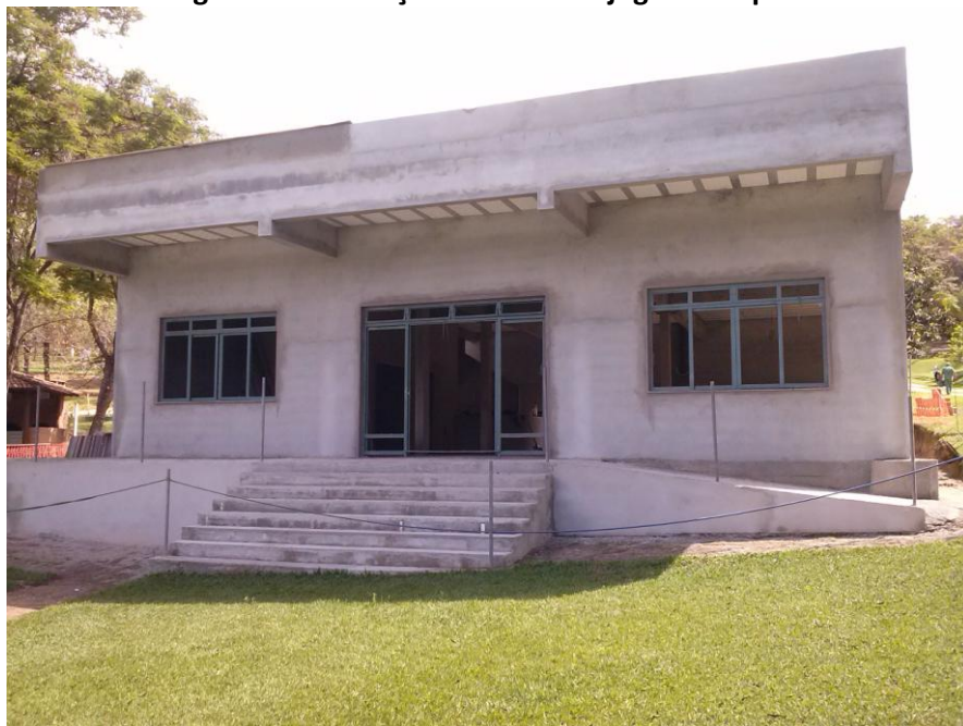
Figura 1: Construção do salão de jogos – Etapa 4
