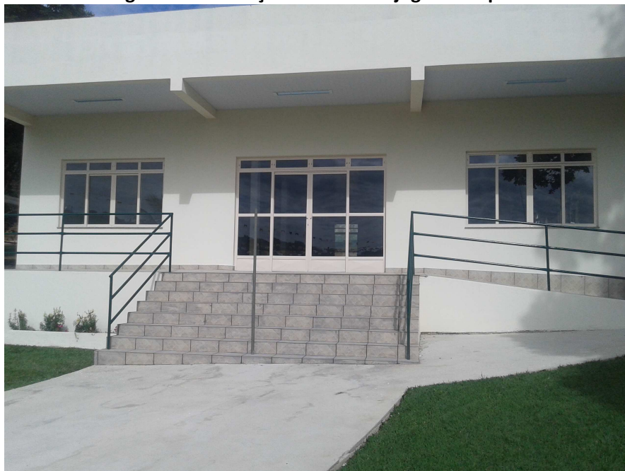
Figura 1: Construção do salão de jogos – Etapa 6
